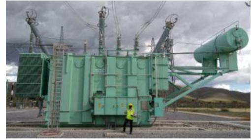
Fig. 4. Fotografía de un transformador de potencia de 120 MVA de Newmont Peñasquito.
